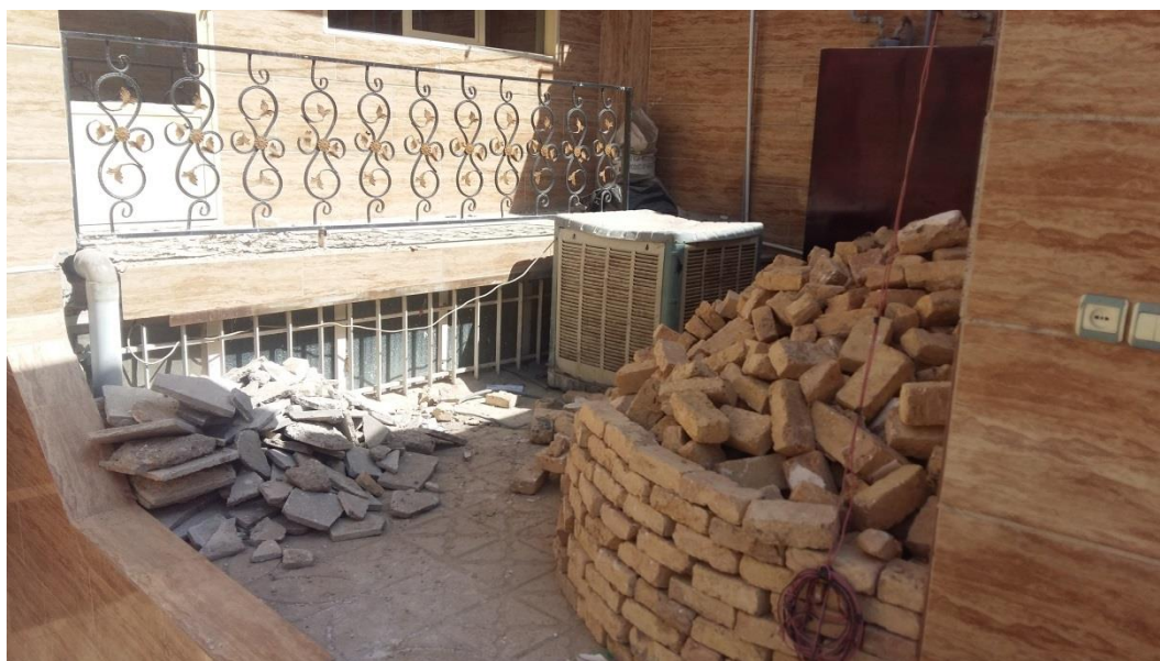
شکل ۲۰ تخریب و تغییر نقشه‌ی ساختمان جدید خانه‌ی علم
